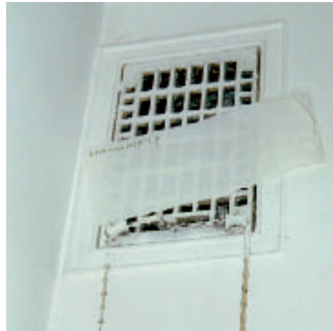
Kuva 1. Asukas voi itse testata paperiarkilla, toimiiko poistoilmaventtiili (pysykö paperi paikallaan). Kuvassa painovoimaisen ilmanvaihdon ristikkoventtiili.
